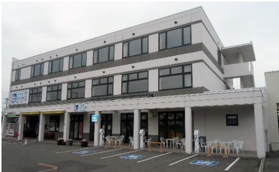
1階 道の駅 3階 商工会事務所
